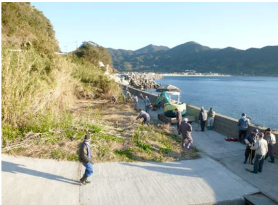
重機による作業
